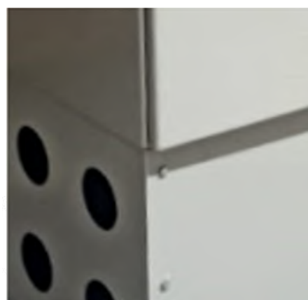
Изготовление и установка дополнительных элементов корпуса
